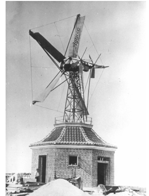
Pumpehuset under opførelse på Amager Strandvej 281-283. Foto 1923.
